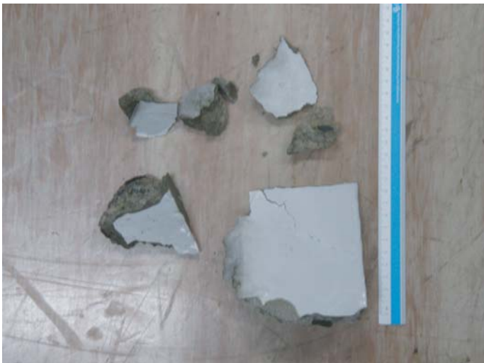
剥落したコンクリート片
