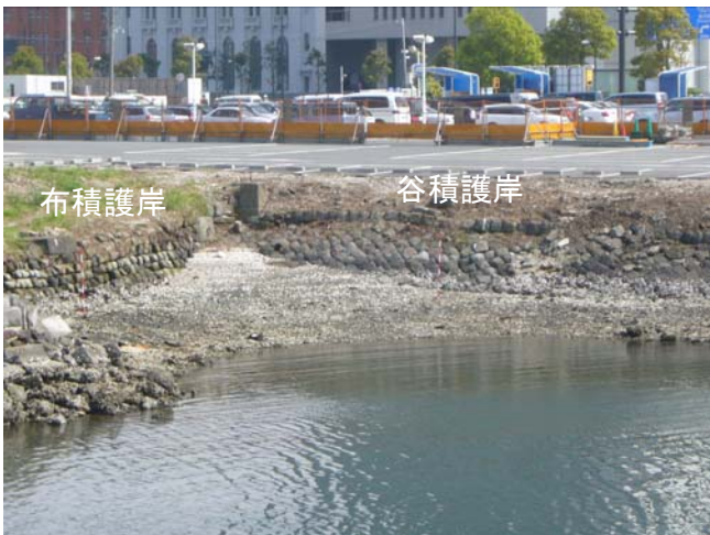
【解体工事前】 左側が布積み護岸、右側が谷積み護岸
