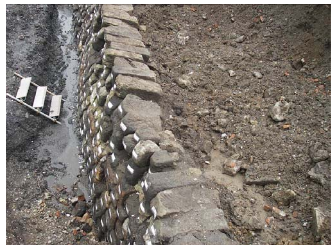
【解体工事中】 解体工事中の布積み護岸
